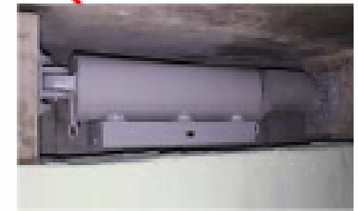
オイルダンパー(4台) (地震の揺れを吸収する)
